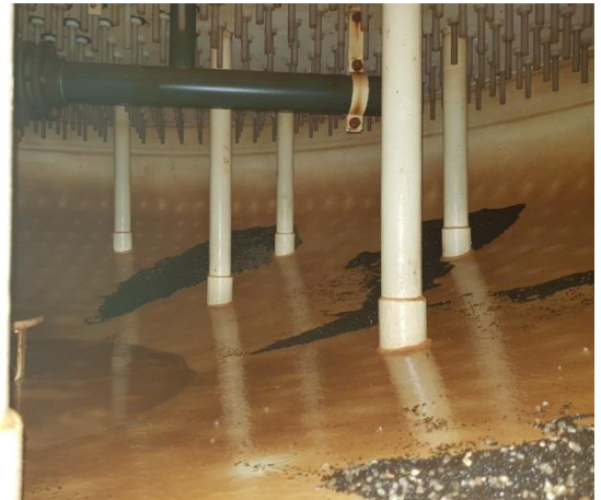
Zustand 2019 - Filtermaterialdurchbruch
