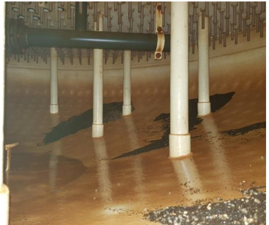
Zustand 2019 - Filtermaterialdurchbruch
