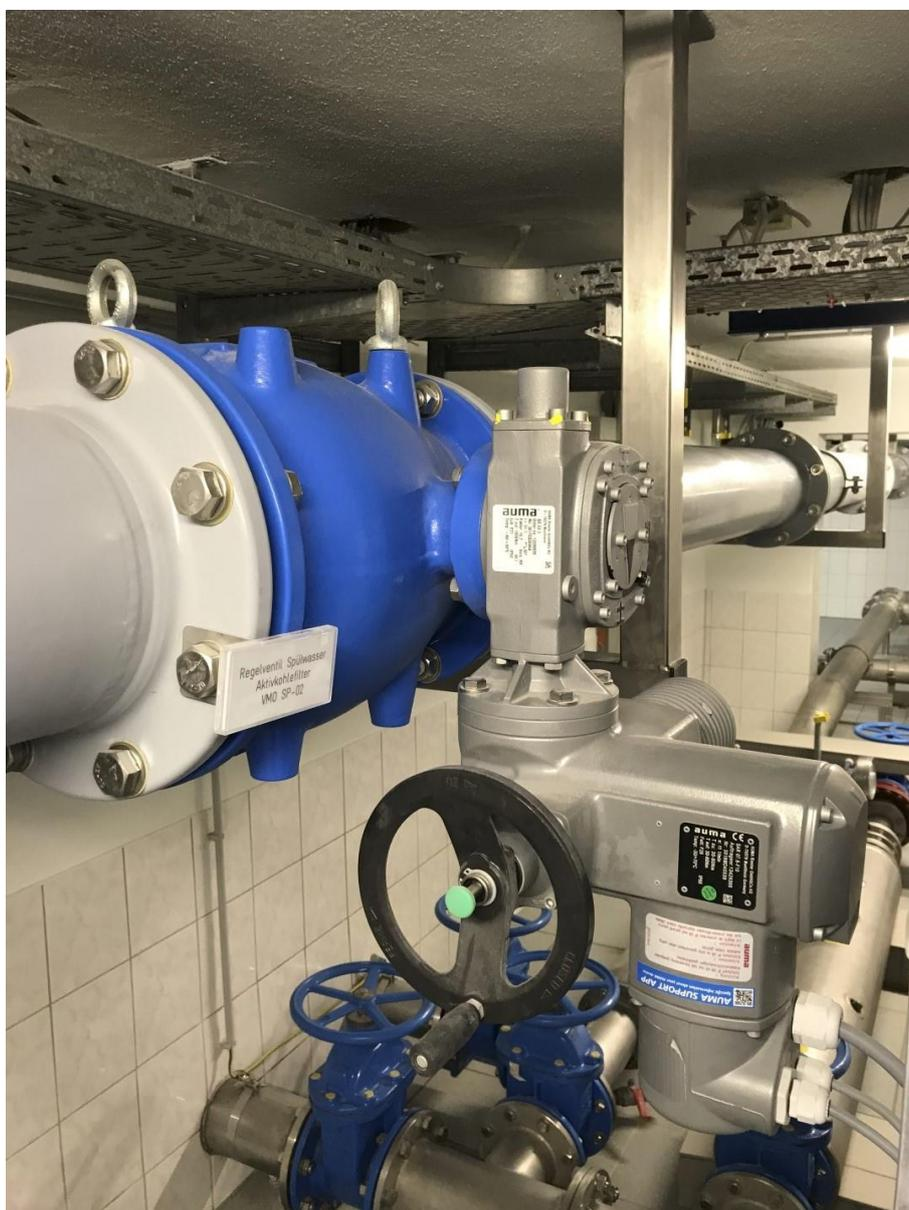
mit aufgebautem Schneckengetriebe AUMA GSM63.3
